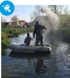
L'action de désensivement du Geer par ensemencement en bactéries, menée en concertation avec les gestionnaires et communes, a pour objectif de diminuer l'impact des rejets d'eaux usées dans le cours d'eau en attente d'un traitement de celles-ci dans une station d'épuration.
